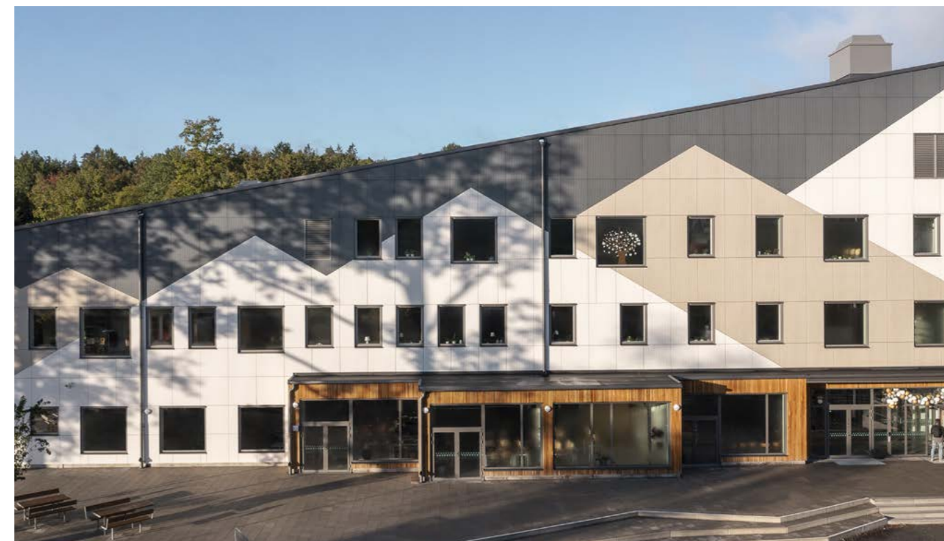
Långsjöskolan Huddinge, Segeltorp, Suède. Architecte: Tyréns, Suède et Arkitema Architects, Danemark. Photographie: BaraBild Sverige AB, Stockholm, Suède.
